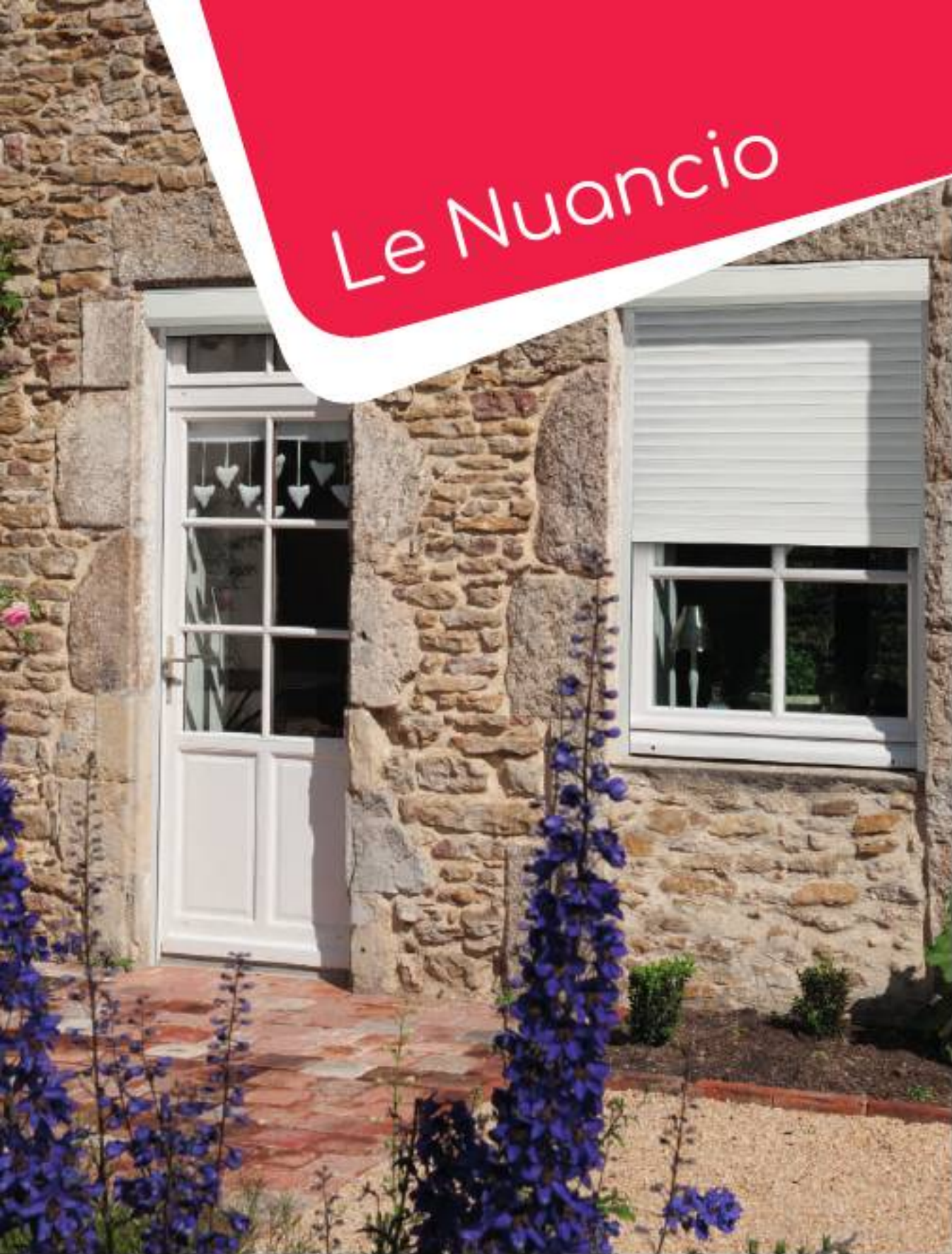
Pose en façade
